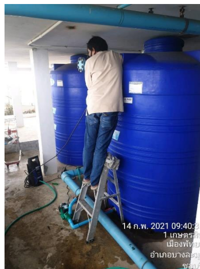
ภาพที่ 16 แสดงการล้างถังเก็บถังน้ำสำรองคาเฟ่
