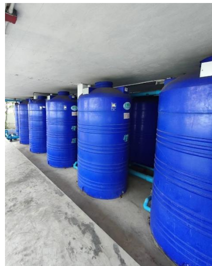
ภาพที่ 10 แสดงถังเก็บน้ำสำรองอาคาร
