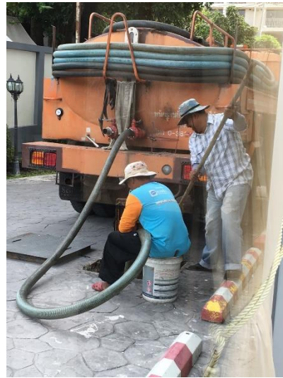
ภาพที่ 8 แสดงการสูบน้ำจากบ่อบำบัดน้ำเสีย
