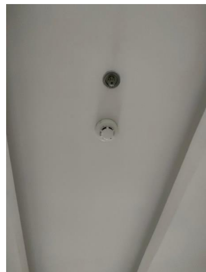
ภาพที่ 36 แสดงอุปกรณ์ตัดจับควันและหัวกระจายน้ำ ดับเพลิง
